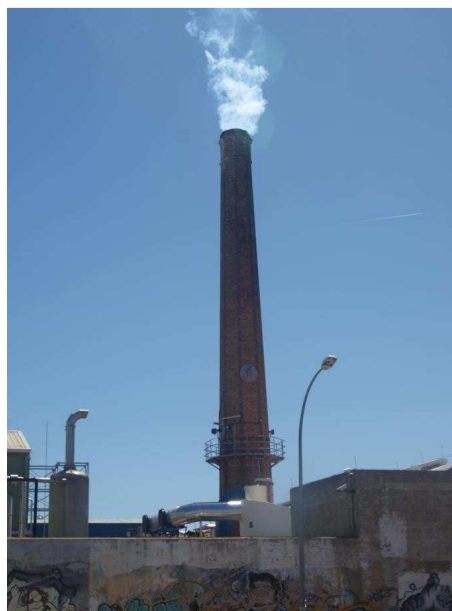
Bien nº 13. Chimenea 1 (DAKSA)
