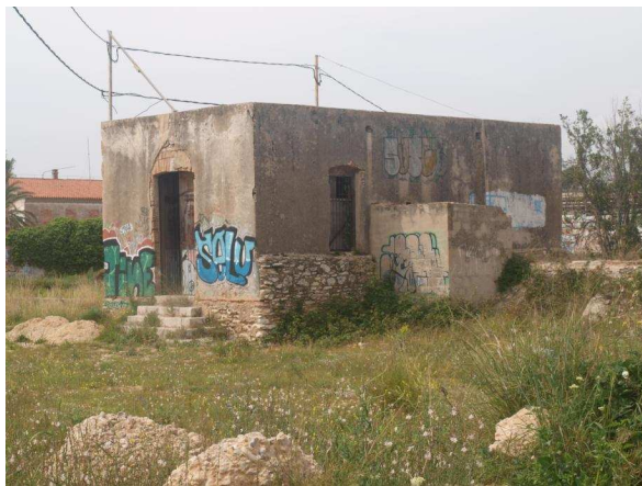
Bien nº 7. Pozo de riego
