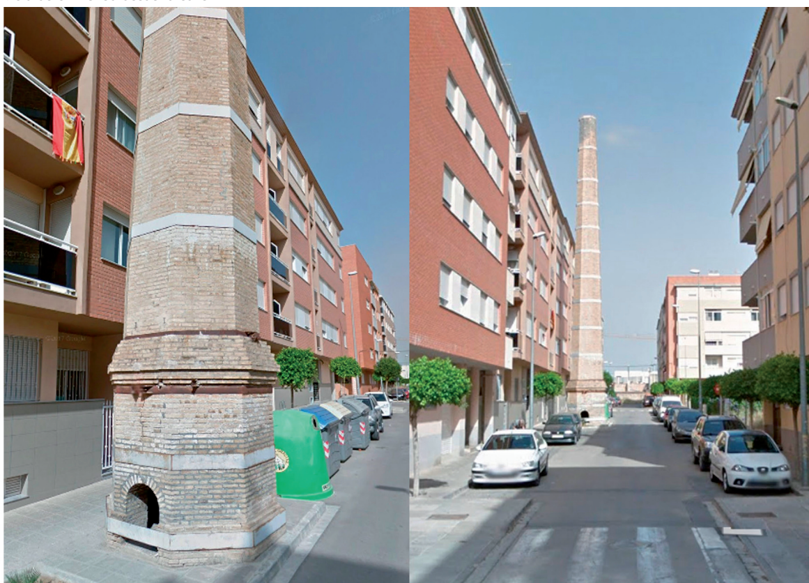
Vista de chimenea desde ambos lados de la calle y base
