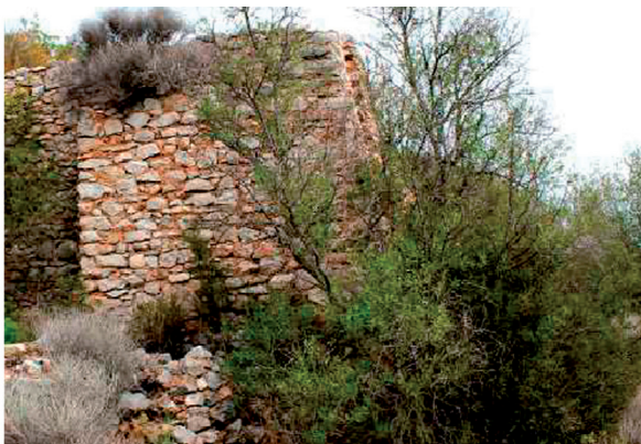
Lateral de la Torre y entrada
