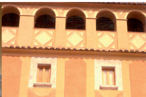
Arcos del lateral
