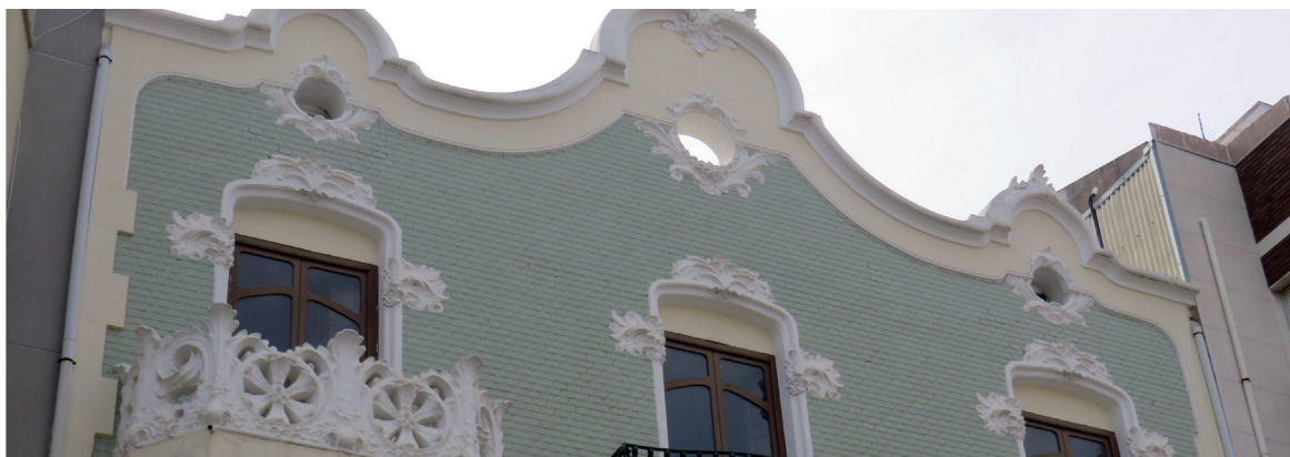
Detalle de espadaña.
