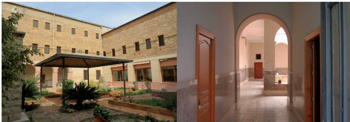
Patio Claustro y acceso a claustro
