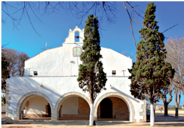
Fachada principal de la Ermita
