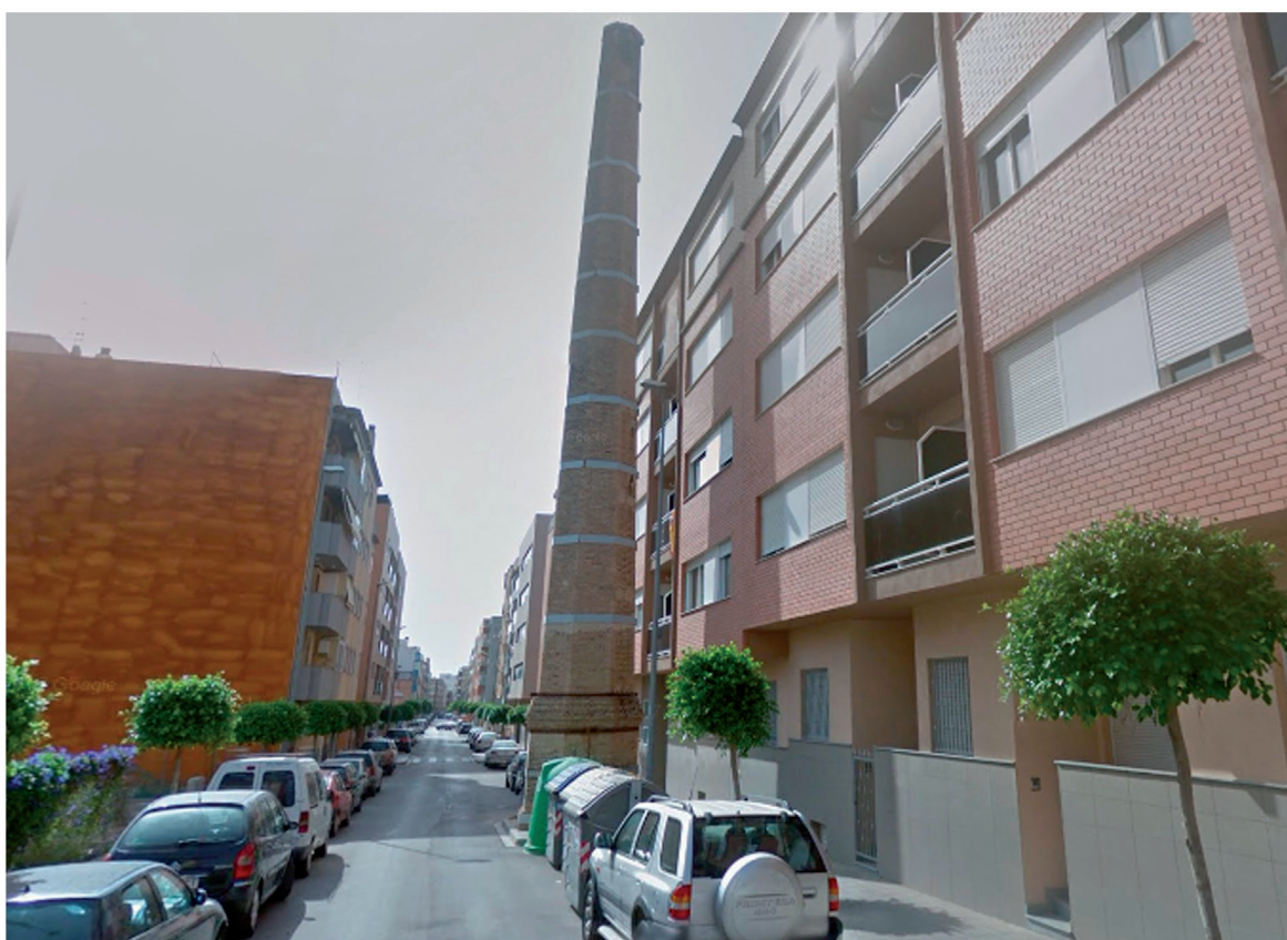
Vista de chimenea desde la calle
