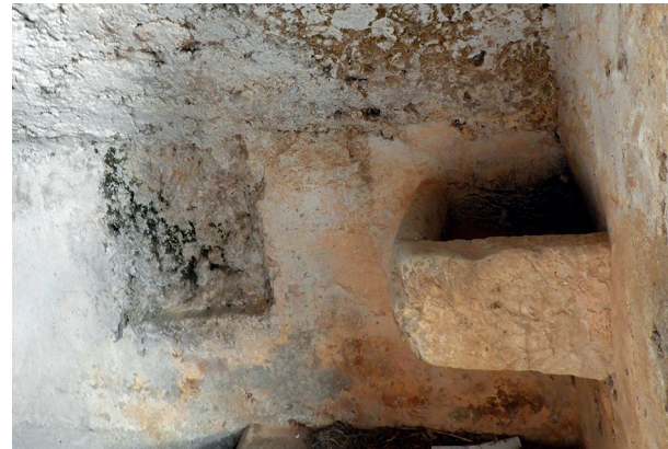
Figura 72: Fotografia d'elaboració pròpia de l'interior de l'aljub.
