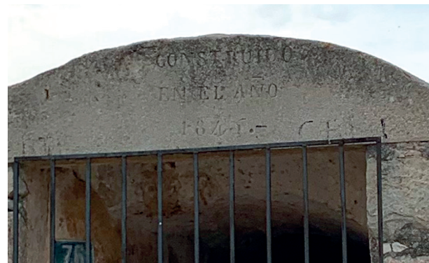
Figura 75: Fotografia d'elaboració pròpia de la llinda de l'aljub.
