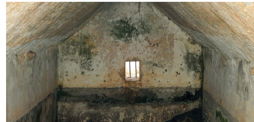
Figura 68: Fotografia d'elaboració pròpia de l'interior de l'aljub.
