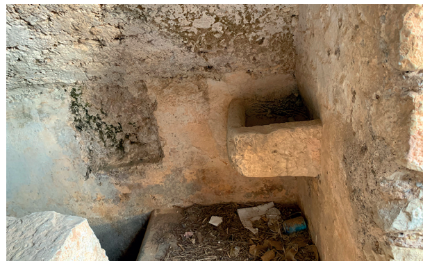
Figura 76: Fotografia d'elaboració pròpia de l'interior de l'aljub.
