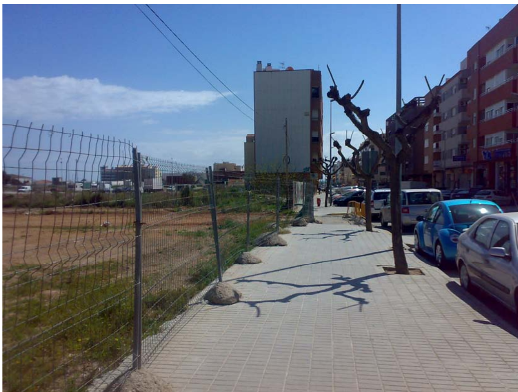
Vista de la acera donde se situarán las rampas.
